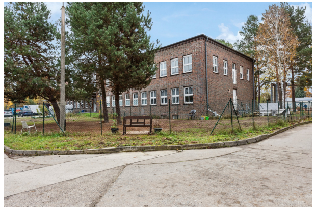
Gebäudeansicht von hinten
